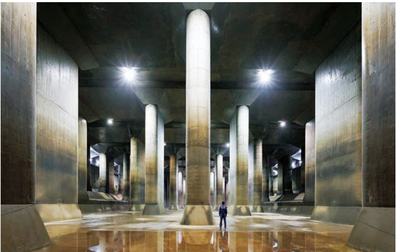
首都圏外郭放水路 調圧水槽
